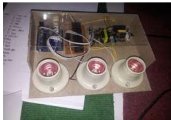
Gambar 8. Pemasangan mika pelindung
